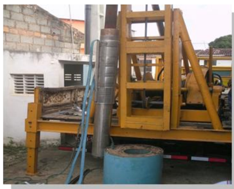
Instalação de novo Conjunto Motobomba na CASAL
